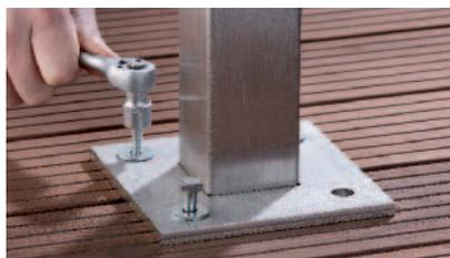
Pfosten ausrichten und montieren.
